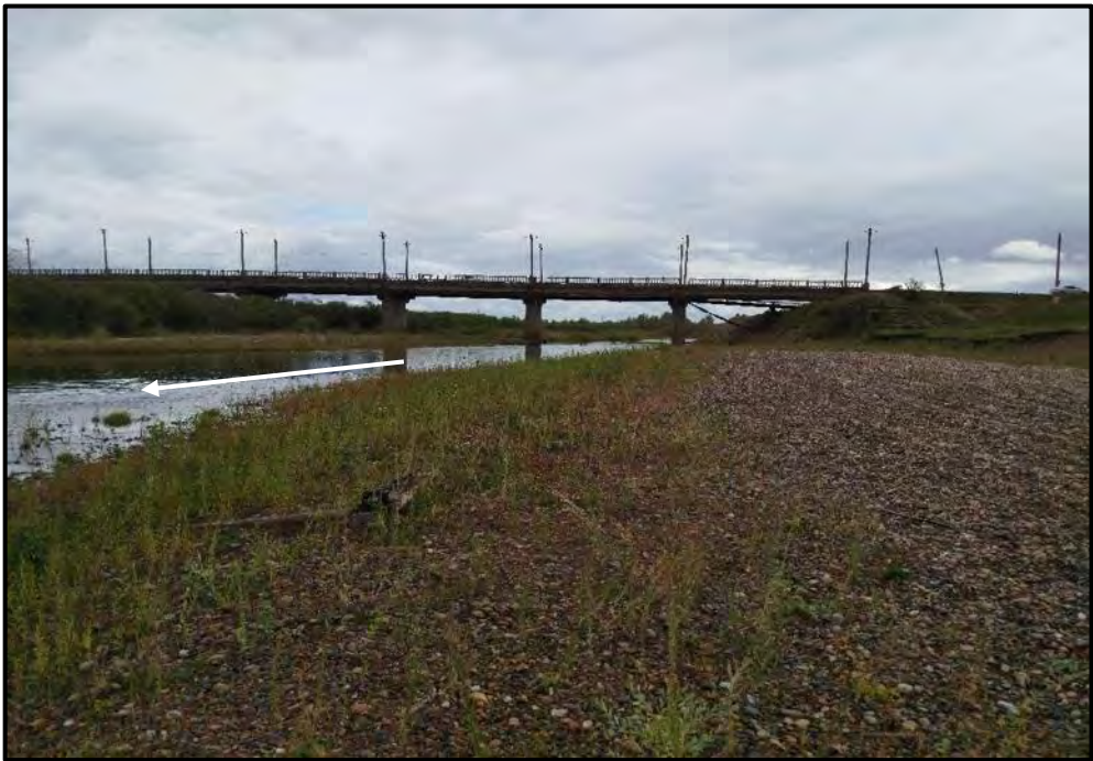
Рисунок Г.5 – Вид с левого берега на мост на р. Унда
